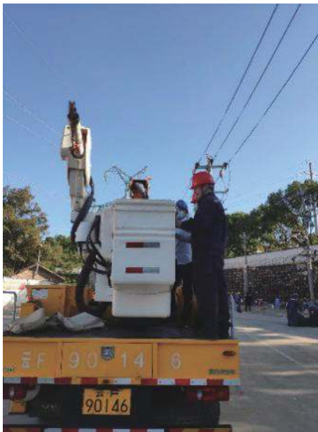
(a) 设备安装
