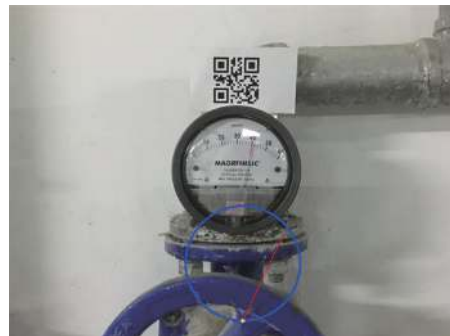
(b) 压差表未使用仪表校正和提取表盘所在区域算法
