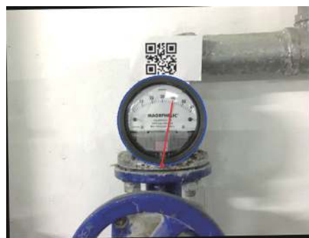
(d) 压差表使用仪表校正和提取表盘所在区域算法
