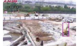
图 4 大型车辆入侵侦测
