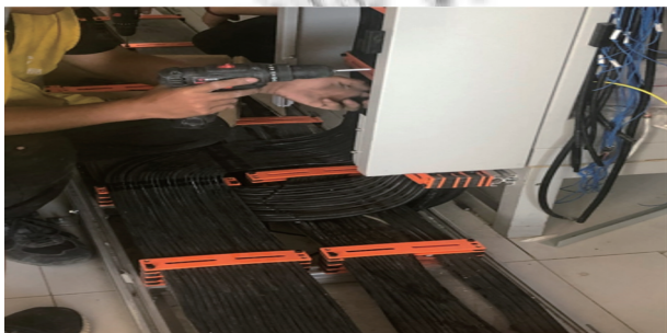
图 14 施工人员依据数字工程模型敷设线缆
