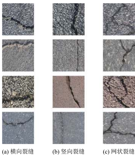
图4 裂缝图像
